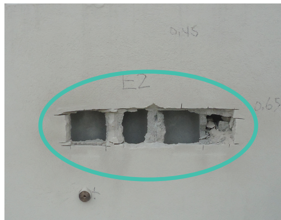
Figura 8 – Parede da platibanda da cobertura. Área do círculo: local de extração dos corpos de prova para realização dos ensaios de absorção de água por capilaridade e de propriedades de transmissão de vapor de água. Ensaio E4, E6, E8 e E9. Fonte: elaborado pelos autores.
