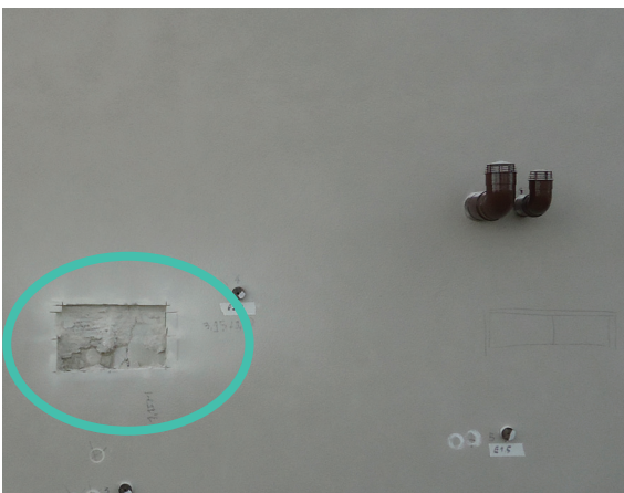
Figura 7 – Parede da casa de máquinas. Área do círculo indica o local de extração dos corpos de prova para realização dos ensaios de absorção de água por capilaridade e de propriedades de transmissão de vapor de água. Ensaios E3, E5, E7 e E9. Fonte: elaborado pelos autores.
