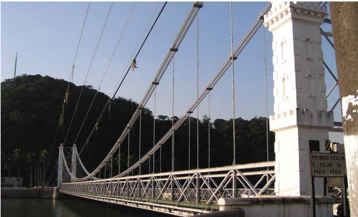
Figura 10 – Ponte Pênsil localizada na cidade de São Vicente – SP. Fonte: elaboração própria.
