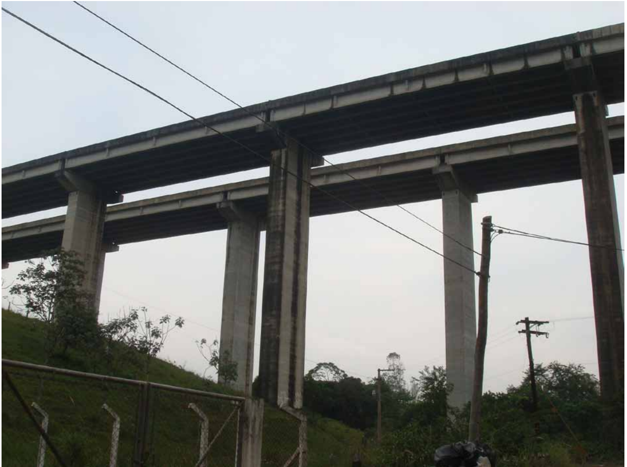
Figura 18 – Outra vista do viaduto mostrado na Figura 17.
