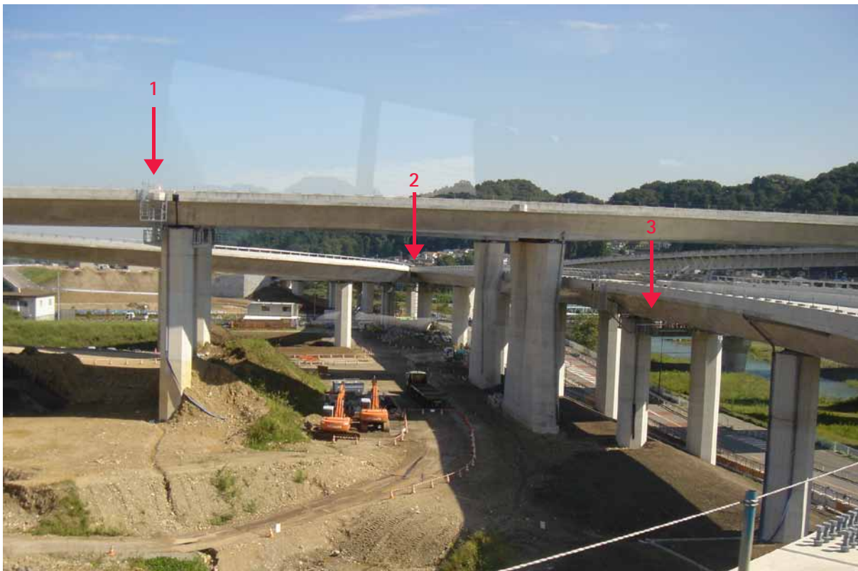
Figura 15 – Plataformas fixas para inspeção e manutenção de sistema viário no Japão. As setas indicam os locais onde estão instaladas as plataformas.
