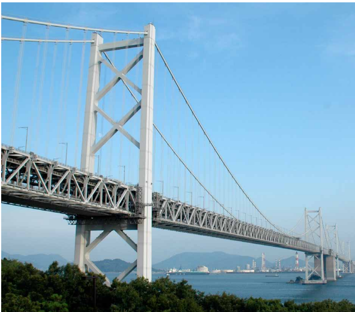
Figura 13 – Ponte Minami Bisan-Seto.
