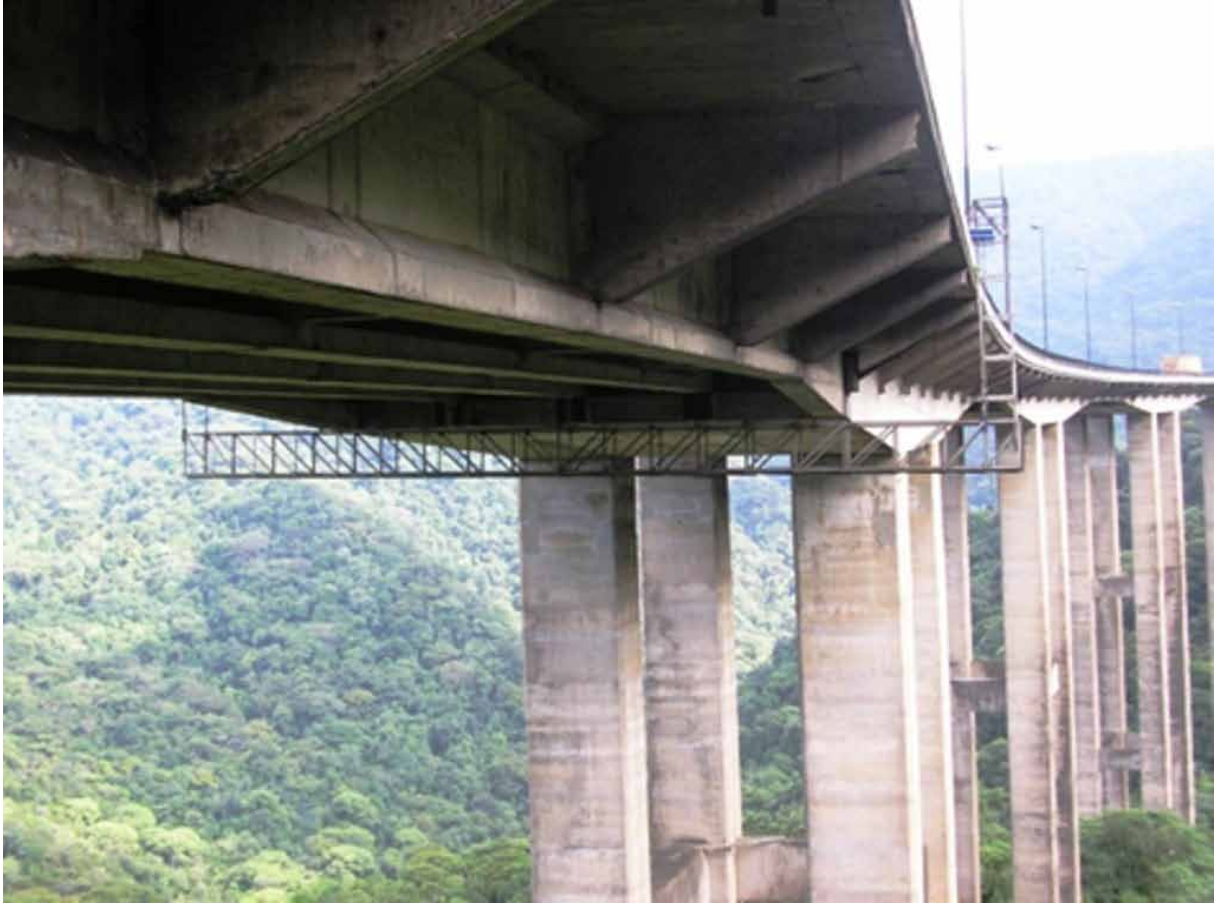
Figura 12 – Plataforma metálica instalada sob o viaduto VA 19 da Rodovia dos Imigrantes em Cubatão – SP, utilizada pela Seção de Engenharia de Estruturas do IPT para os trabalhos de inspeção. Fonte: elaboração própria.
