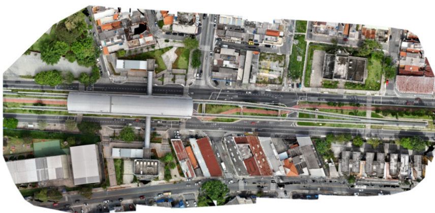
Figura 10 – Ortomosaico do primeiro do trecho visitado na linha 15-Prata (estação Camilo Haddad) em 19/04/24. Dados gerados por drone em voo manual.
