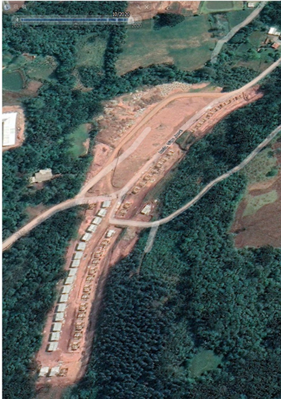
Figura 7 - Andamento das obras do loteamento Bom Jesus em outubro de 2020 - cenário base deste estudo
