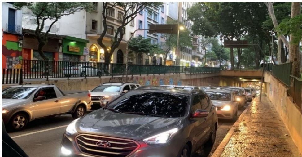
Figura 3 – Emboque 4 do Túnel Presidente Roosevelt
