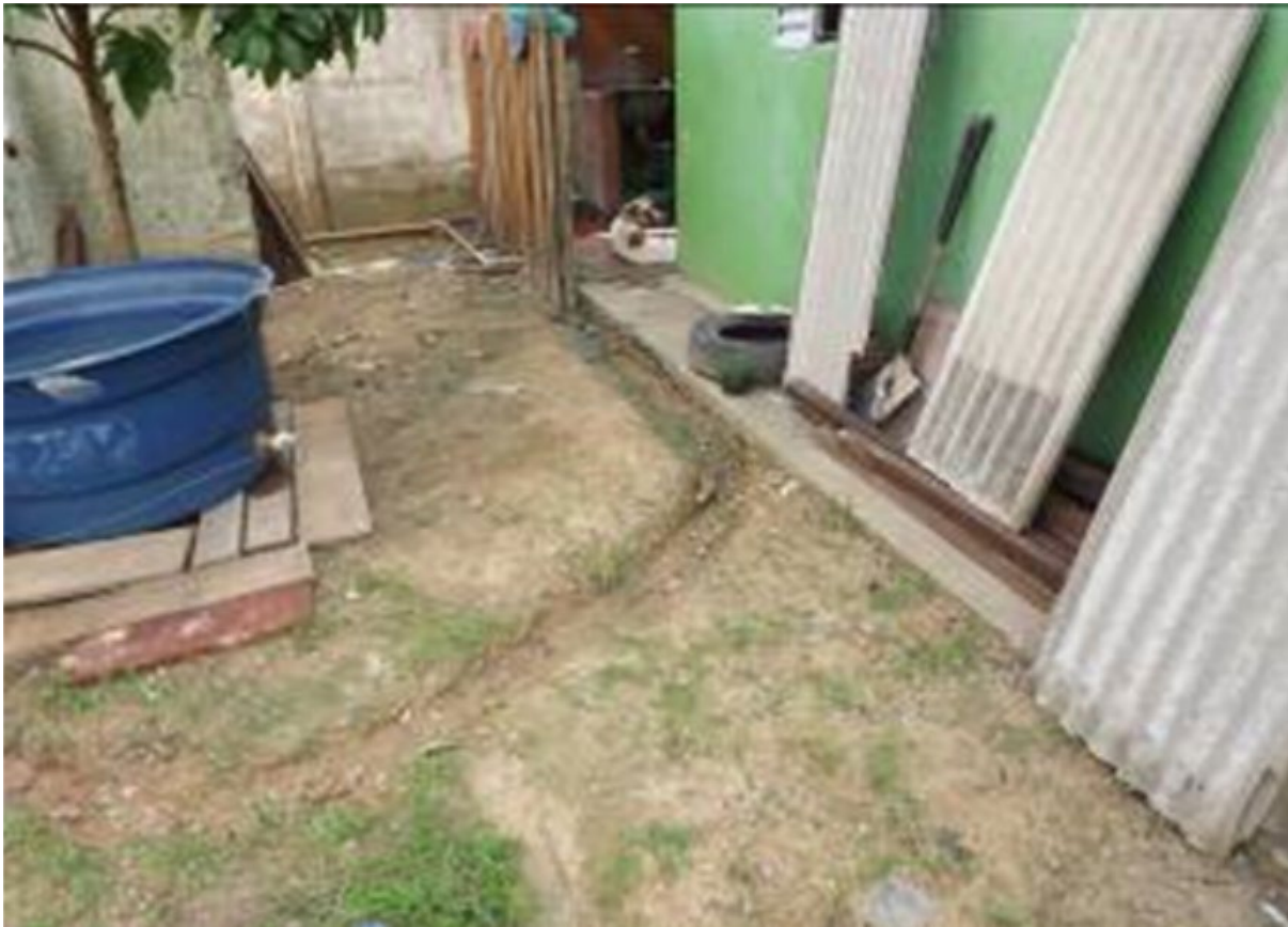
Figura 5 – Canaletas de drenagem no entorno do radier
