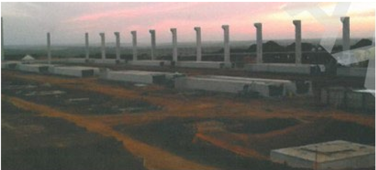
Figura 2 – Edificações industriais em pré-moldados de concreto armado em canteiro
