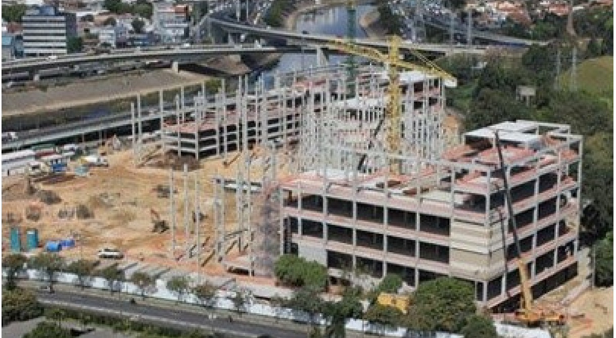
Figura 1 – Edificações de shopping centers em pré-moldados de concreto armado em canteiro
