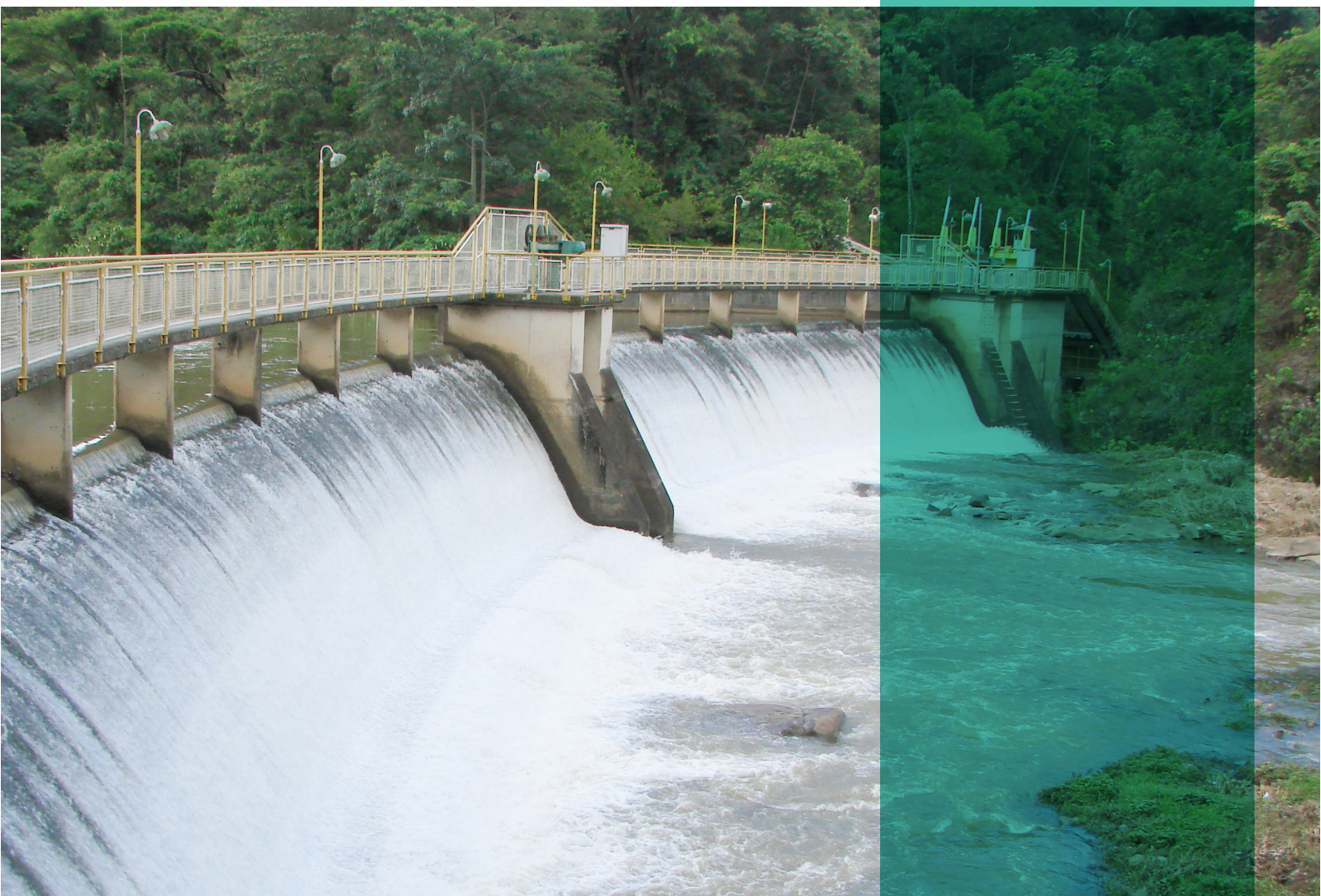
Foto: Usina Hidrelétrica Eng. Pedro Affonso Junqueira (Antas I), Poços de Caldas. Autor: Eduardo Luiz Machado
