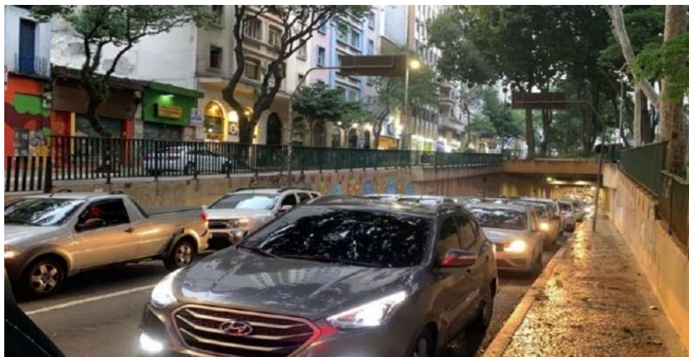
Figura 3 – Emboque 4 do Túnel Presidente Roosevelt
