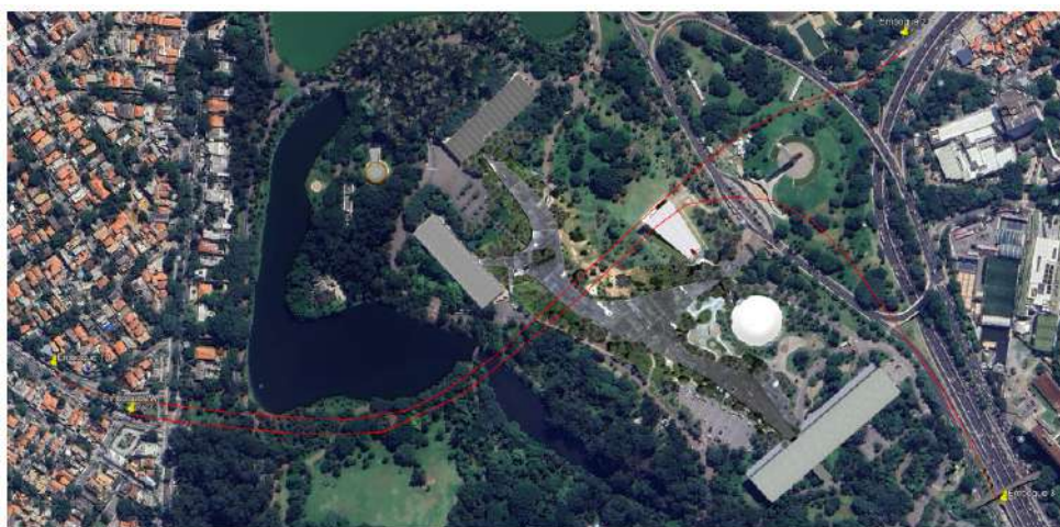
Figura 1 – Localização dos Emboques dos Túneis do Complexo Ayrton Senna
