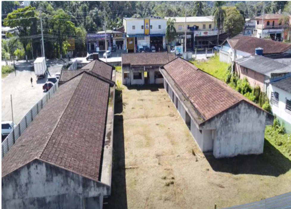
Figura 6 – Vista aérea da construção da creche municipal
