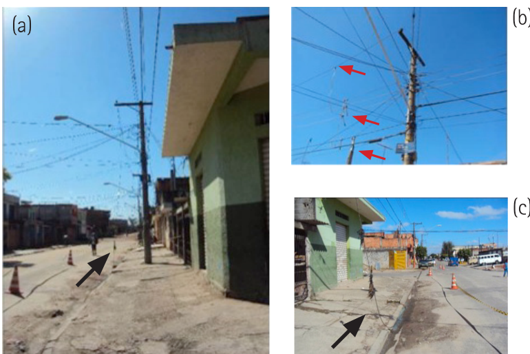
Figura 2 – (a) Local do acidente. A seta aponta para o cabo caído. (b) A seta preta aponta para o cabo rompido. Observe restos de rabiolas de pipas presas aos cabos (setas vermelhas). (c) Observe como o cabo rompido toca o chão na altura do meio fio (seta).
