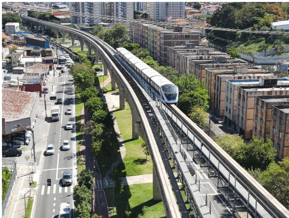
Figura 12 – Registro durante teste dedicado a identificar eventuais interferências que a passagem de trem poderia causar no voo do drone. Registro feito por drone em 19/04/24 no primeiro trecho visitado da linha 15-Prata.
