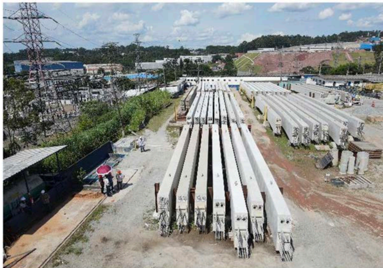
Figura 2 – Vista geral do pátio de vigas da linha 15-Prata. Registro oblíquo convencional feito por drone na visita técnica de 05/02/24.
