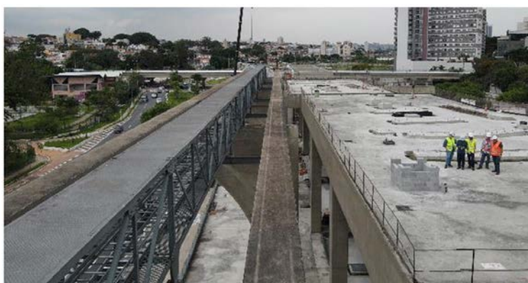
Figura 7 – Exemplo de registro oblíquo feito para a caracterização geométrica das vigas. Registro feito por drone no segundo trecho visitado da linha 17-Ouro em 18/03/24.
