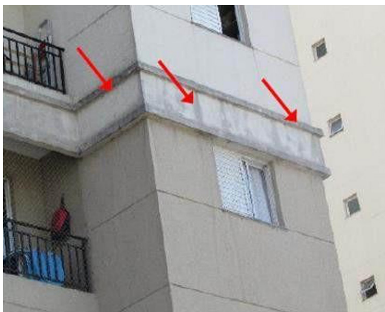
Fotografia 6: Vazamento na fachada decorrente de intervenção realizada pelo proprietário na tubulação do medidor de água durante reforma da unidade.
