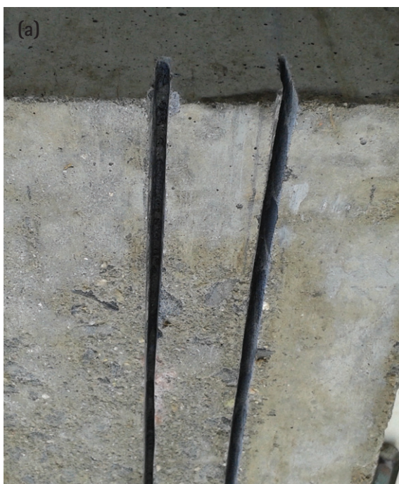
Figura 2 – Técnica NSM : (a) entalhes realizados no cobrimento de concreto da região tracionada da viga; (b) laminados de PRFC inseridos e colados nos entalhes realizados. Fonte: elaboração própria.
