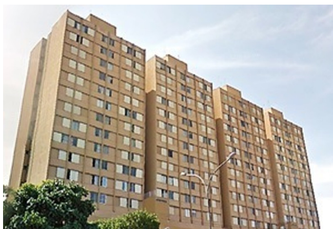
Figura 1 – Central Parque da Lapa. Conjunto de edifícios em alvenaria estrutural.
