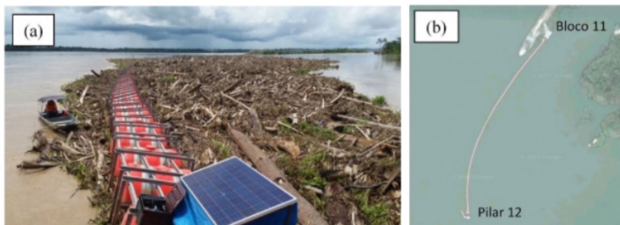
Figura 2 – Trecho do sistema em operação no período de cheia (a) e vista aérea sem detritos acumulados (b)
