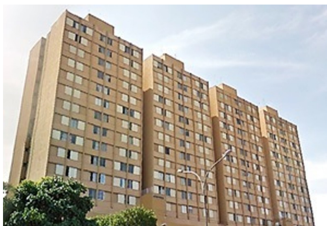
Figura 1 – Central Parque da Lapa. Conjunto de edifícios em alvenaria estrutural.
