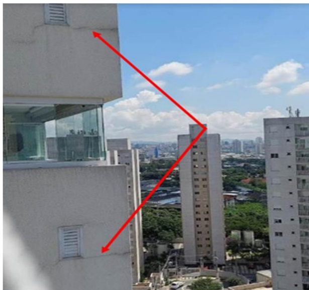
Fotografia 1: Falha de projeto evidenciada pela repetição de trincas nos terraços da fachada
