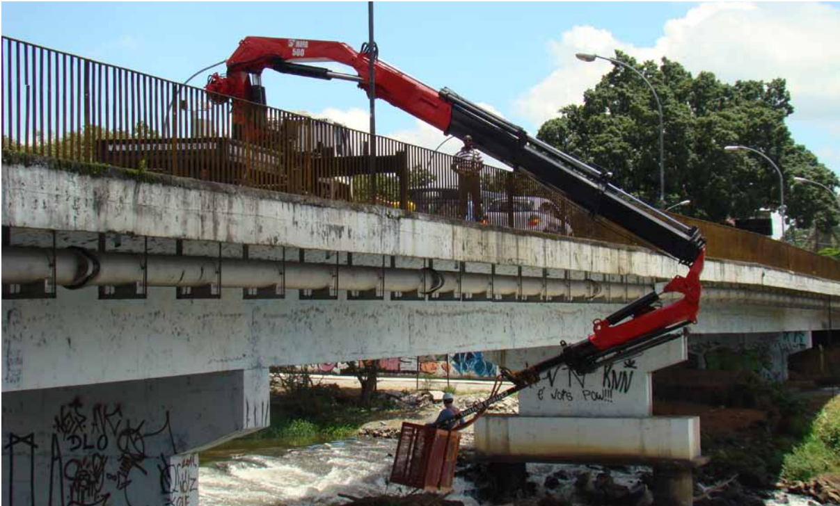
Figura 7 – Inspeção realizada pela equipe do IPT na região inferior do tabuleiro da ponte, realizada com o auxílio de caminhão provido de dispositivo mecânico articulado e com cesto. Fonte: elaboração própria.
