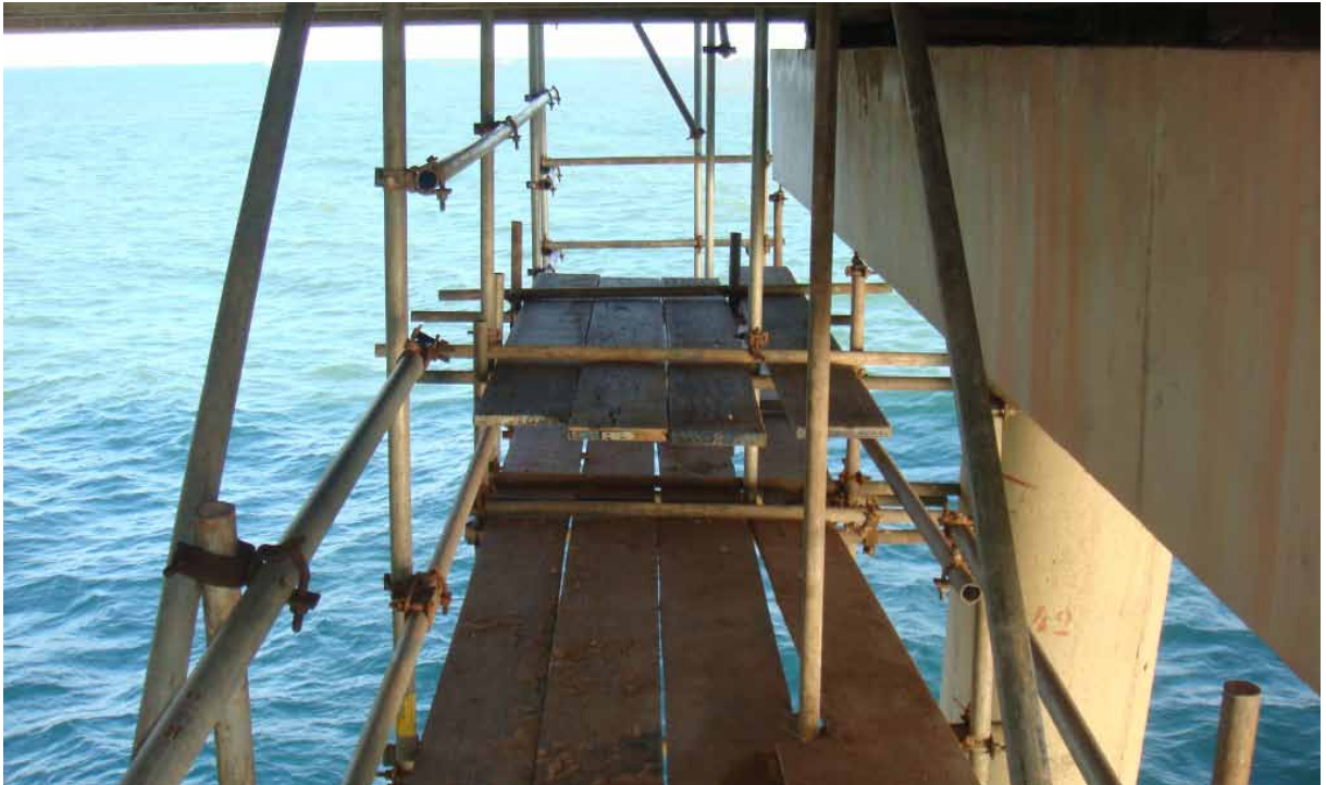
Figura 7 – Inspeção realizada pela equipe do IPT na região inferior do tabuleiro da ponte, realizada com o auxílio de caminhão provido de dispositivo mecânico articulado e com cesto.
