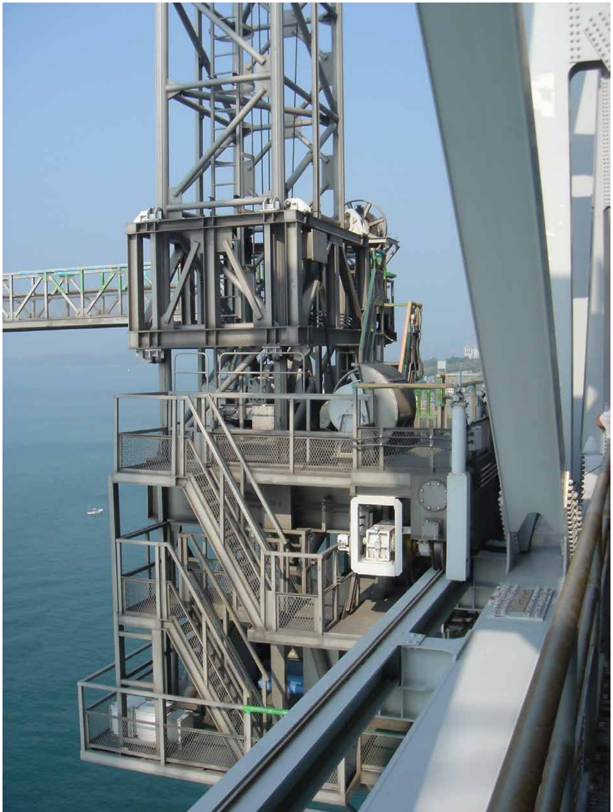
Figura 14 – Vista do acesso à plataforma móvel, mostrada na Figura 13. Fonte: elaboração própria.
