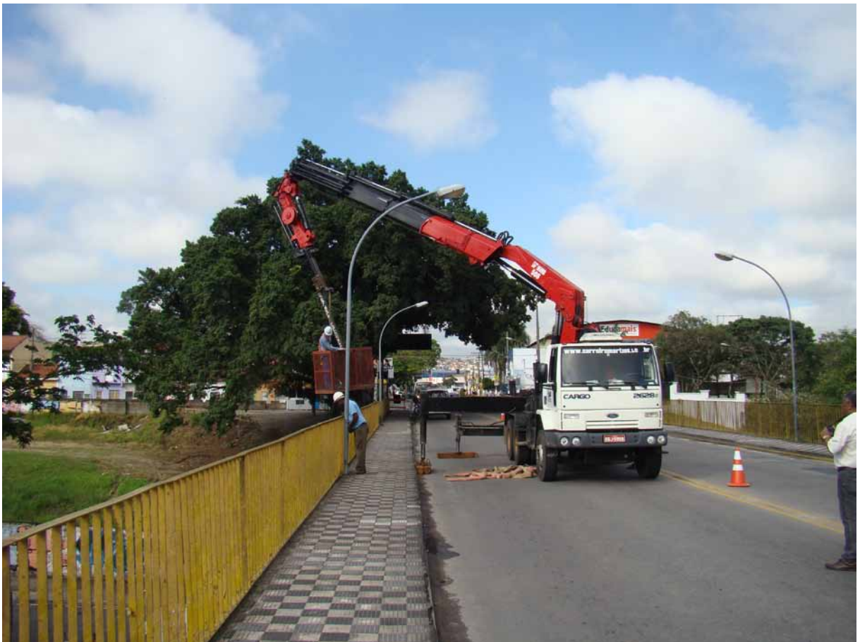
Figura 6 – Inspeção realizada em ponte com auxílio de caminhão com dispositivo mecânico articulado – Interdição de uma faixa de rolamento para posicionamento do caminhão.
