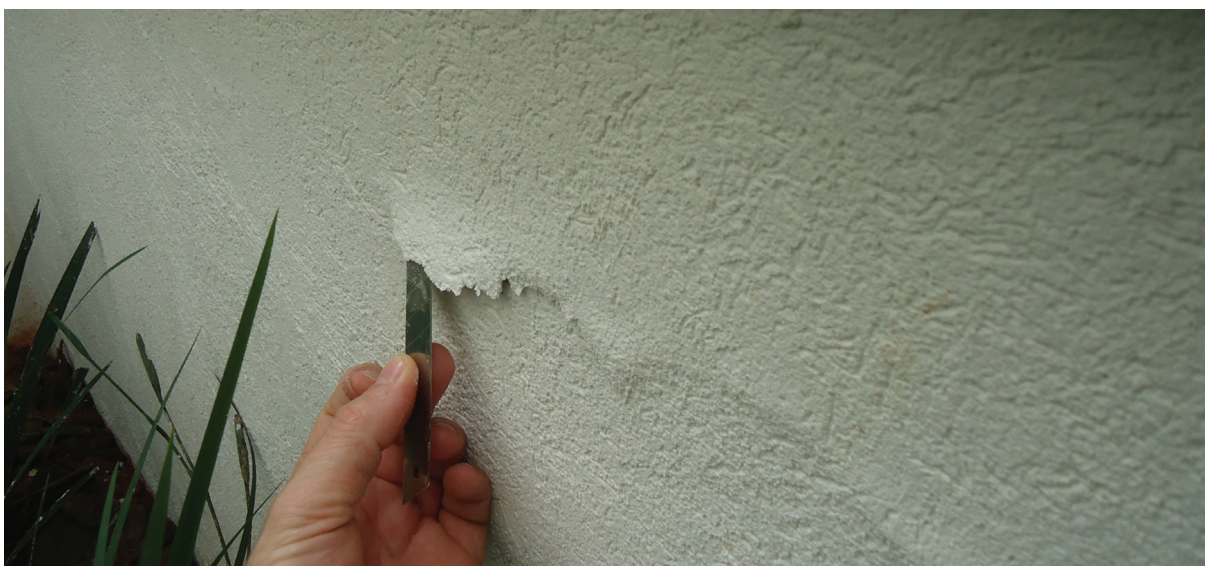
Figura 5 - Região da Figura 4 vista de outro ângulo. Remoção da bolha com lâmina cortante. Fonte: elaborado pelos autores.
